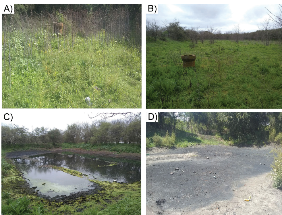
Figura 1. Laguna de estabilización colmatada-L1 (A), laguna de estabilización colmatada-L2 (B) y laguna de estabilización parcialmente colmatada-L3 en septiembre de 2021 (C) y marzo de 2022 (D).
